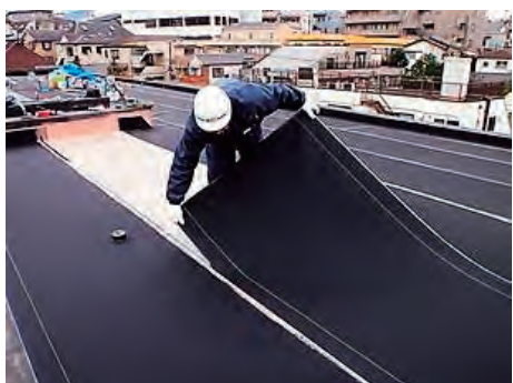
施工現場の風景
