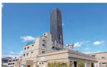
広告塔解体工事中
