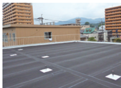
敷設後・塗装前
