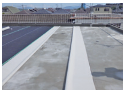
シート敷設工程
