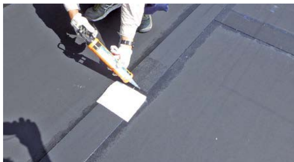
●テープ相互の段差にはシールを充填する。
