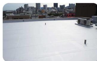
屋上防水 施工例
