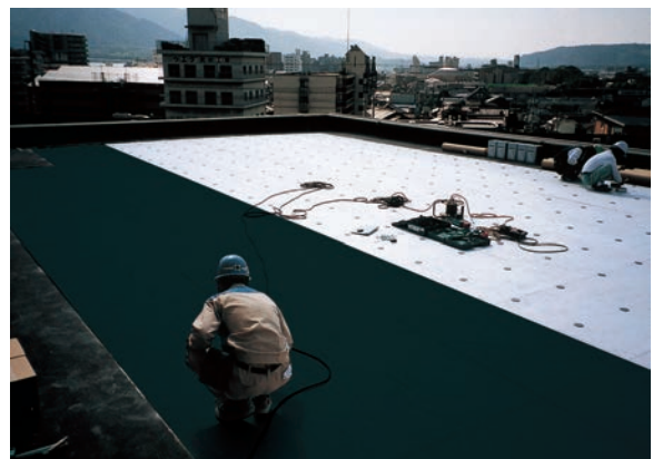
(シートの張付け)
