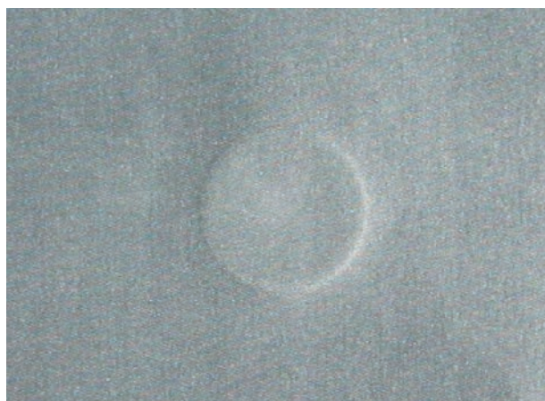
融着状況(シート外観)
