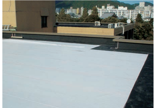
(絶縁シートの敷設)
