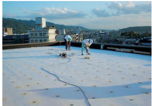
(固定金具の取付け)
