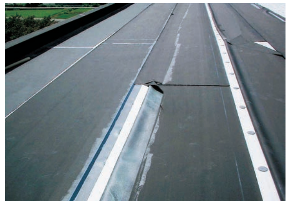
（シートの接合部の張付け）
